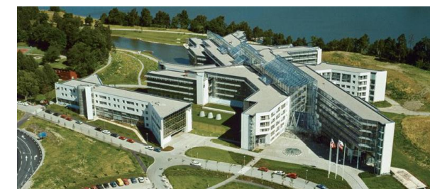
Slika 2; Niels Torp, Sjedište tvrtke SAS, 1985./pogled na kompleks
