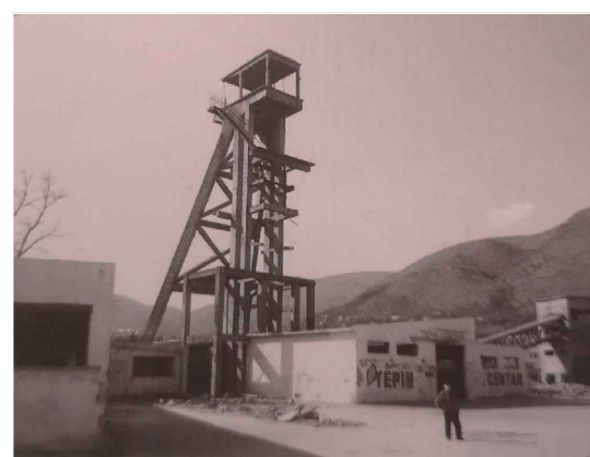
Izvozno okno - jama Novo okno
