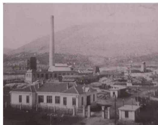
Termoelektrana s rashladnim uređajem
