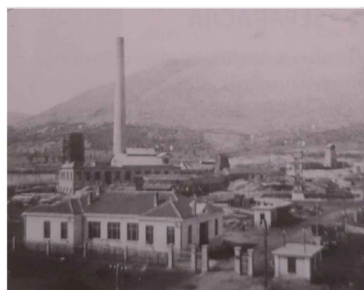
Termoelektrana s rashladnim uređajem
