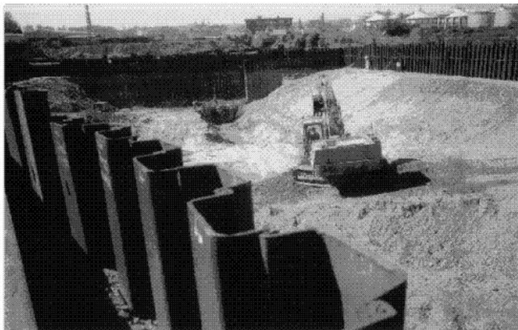
Slika 6. Zaštita iskopa građevne jame čeličnim žmurjem [1]
