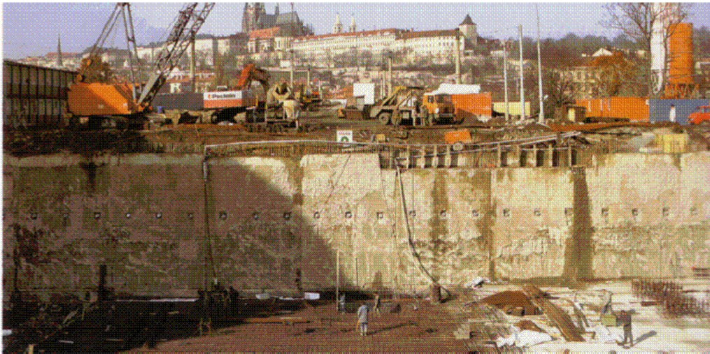
Slika 1. Građevna jama zaštićena usidrenom dijafragmom [13]
