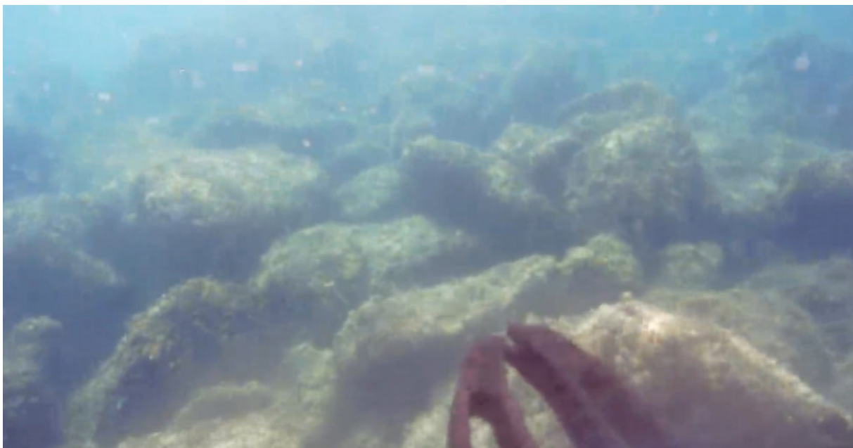
Slika 8.1.2. Podvodna fotografija postojećeg lukobrana napravljena bespilotnom ronilicom
