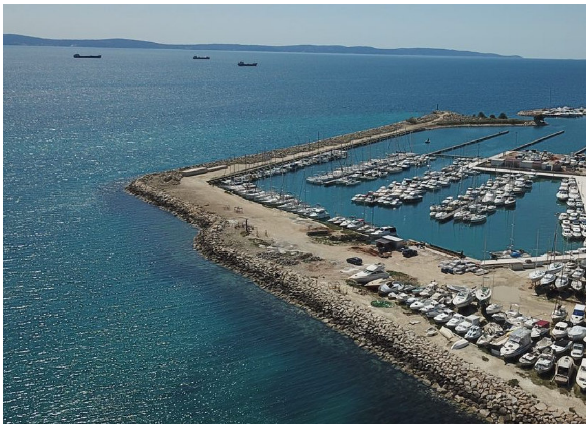
Slika 8.1.1. Trenutno stanje lukobrana Zenta
