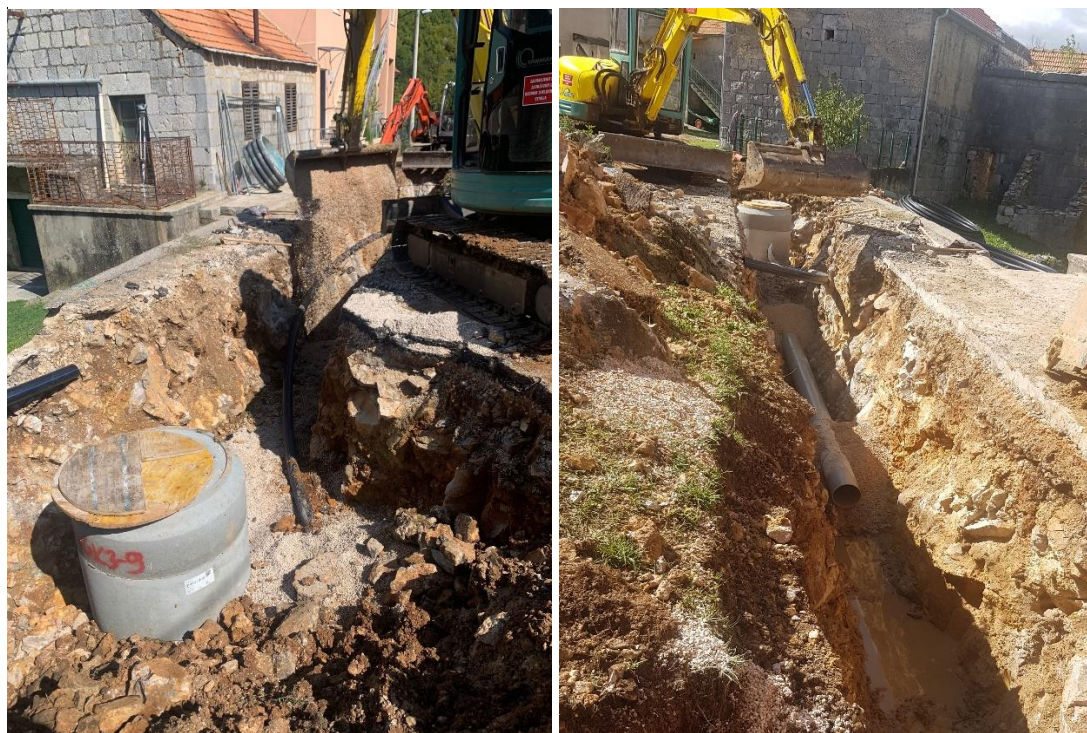
Fotografija 2. i 3. Iskop rova za polaganje cijevi i okana uz kućne prilaze stanovnika
