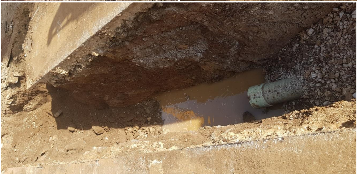
Fotografija 4., 5. i 6. iskop rova i postava geotekstila u mekanom tlu C kategorije
