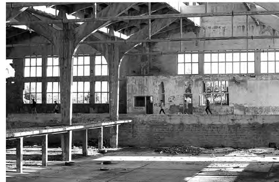
Obilazak lokacije / Site visit
