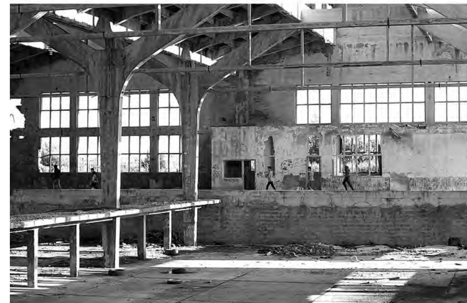
Obilazak lokacije / Site visit
