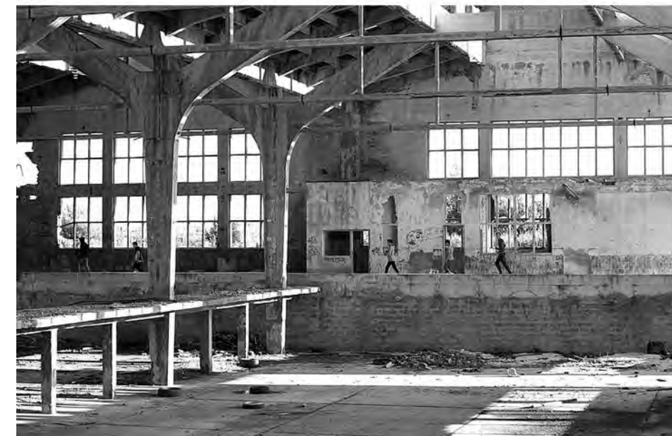
Obilazak lokacije / Site visit
