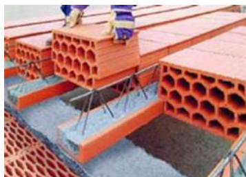
Slika 6.44 – Sustav Fert – Postavljanje ispuna na gredice
