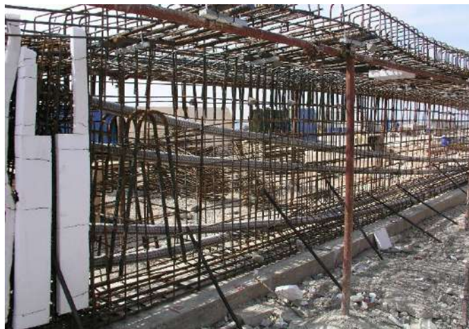
Slika 7.8 –Unutarnje prednapinjanje
