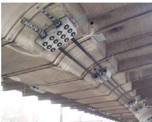
Slika 7.9 –Vanjsko prednapinjanje [20] & [21]
