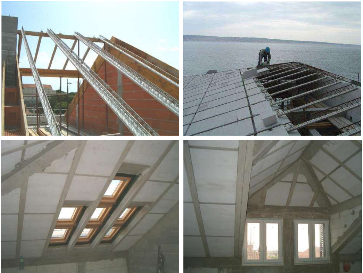
Slika 6.49 – Neki detalji izvedbe Bijelog stropa
