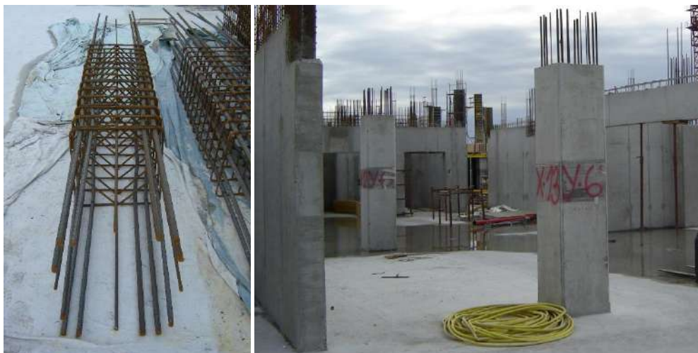
Slika 6.68 – Neki detalji izvedbe stupova
