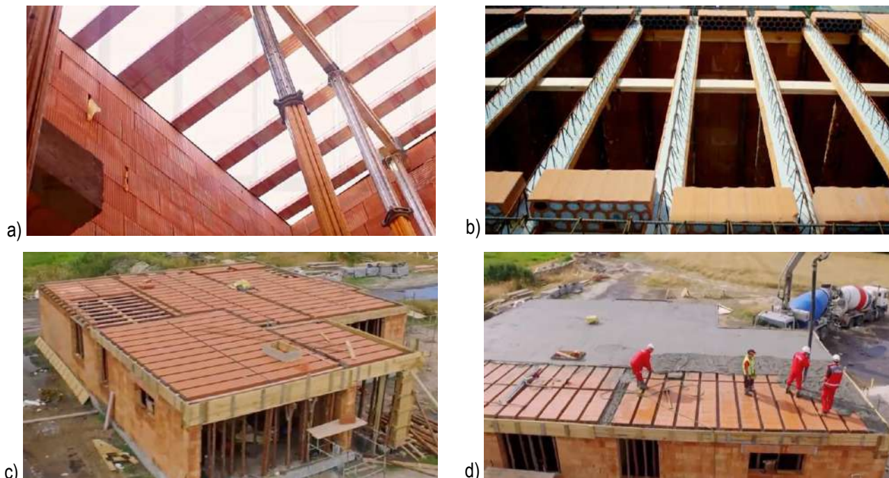
Slika 6.47 – Sustav Fert – Faze izvedbe Fert stropa
