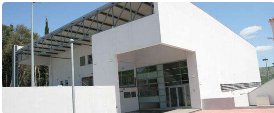
Slika 6.93 – Školska sportska dvorana Dugopolje – konzolni zidni nosač
