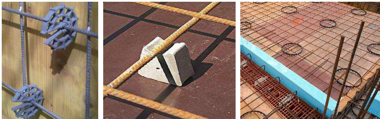
Slika 2.26 – Neki primjeri ugradnje distancera
