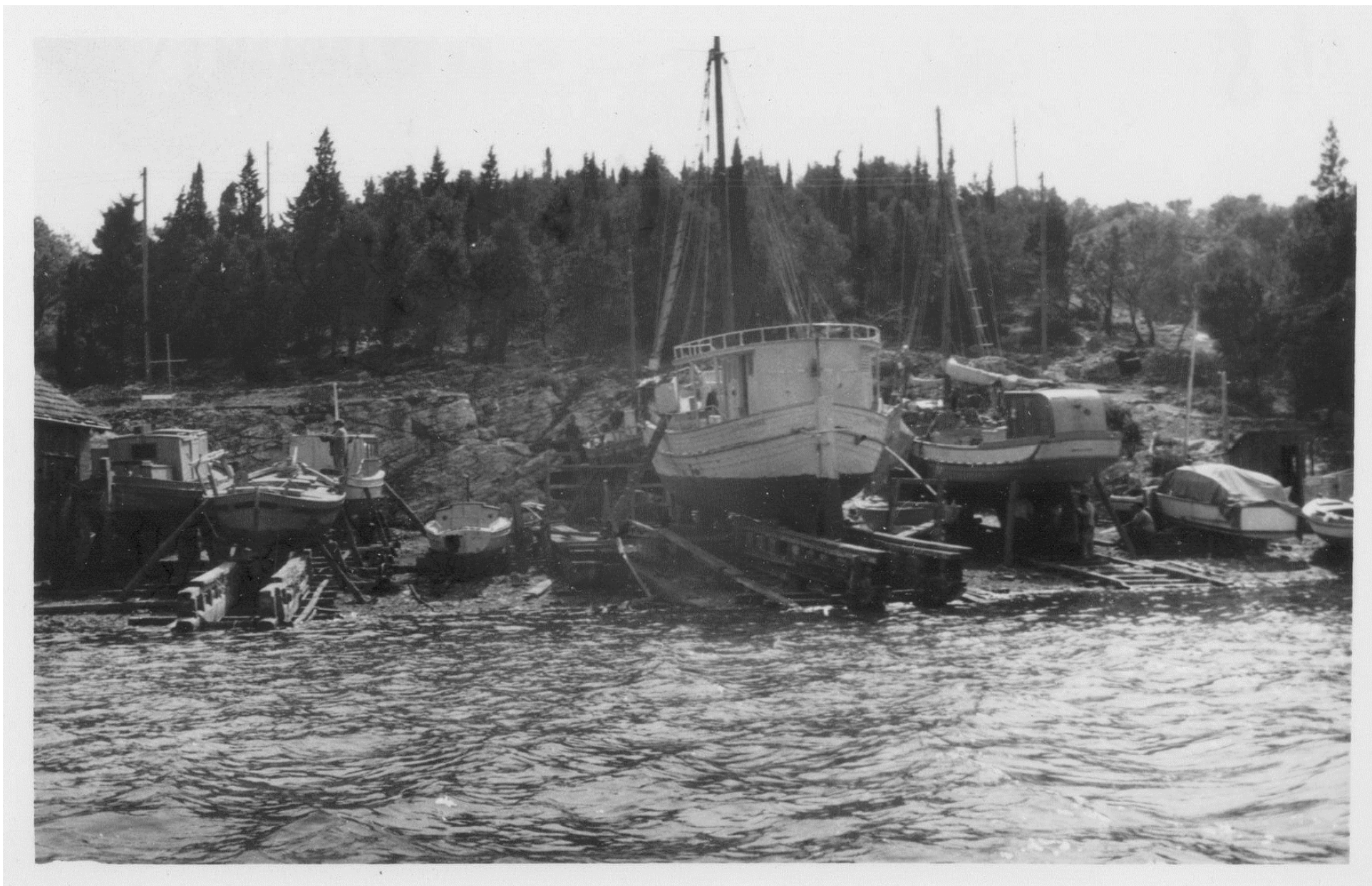
28. Remont brodova u milnarskom brodogradilištu u drugoj polovici 20.st., bivše brodogradilište Dorić
