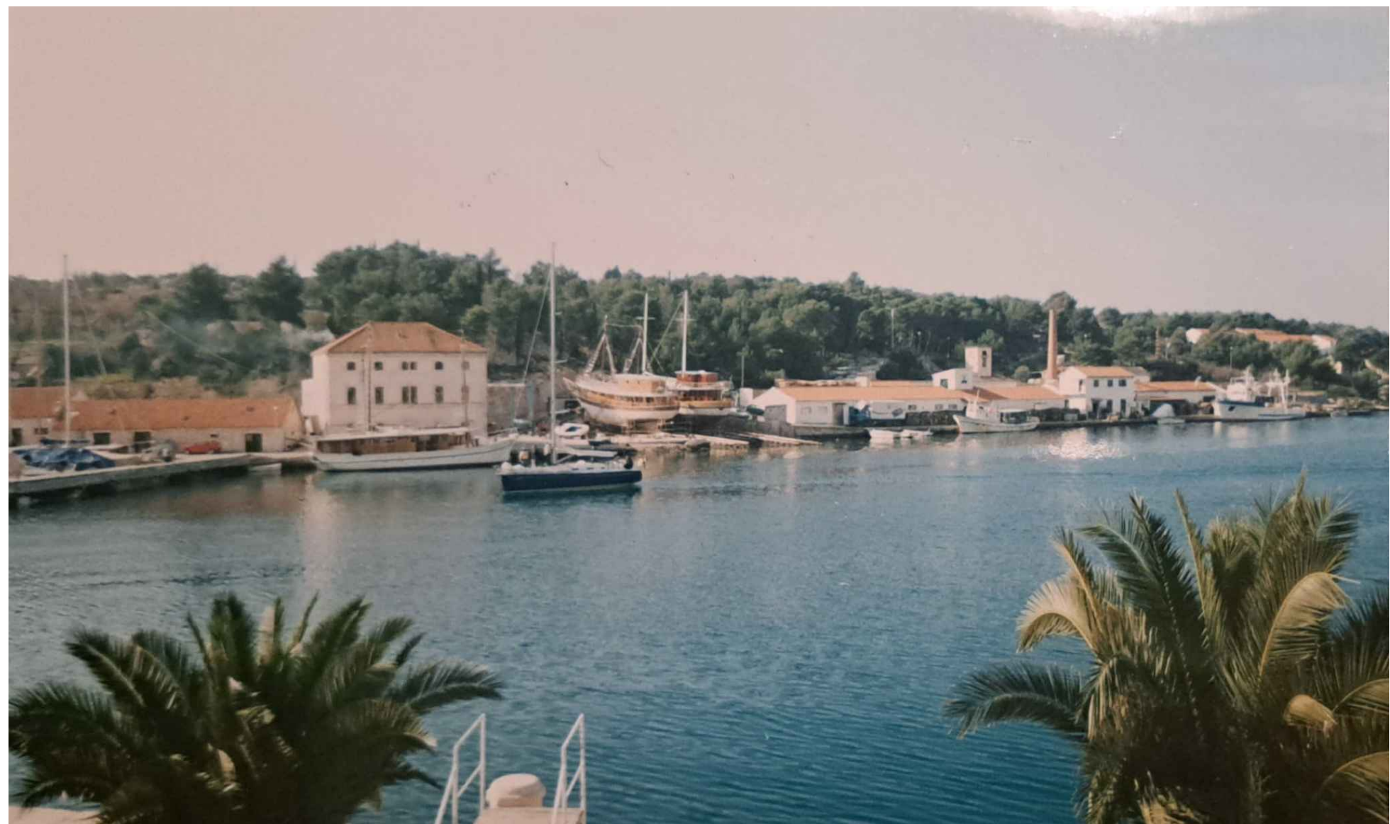
41. S lijeva na desno: Bijela kuća (nekadašnji parni mlin), Škver (milnarsko brodogradilište), Tvornica ribe Sardina. Fotografija iz 2005.
