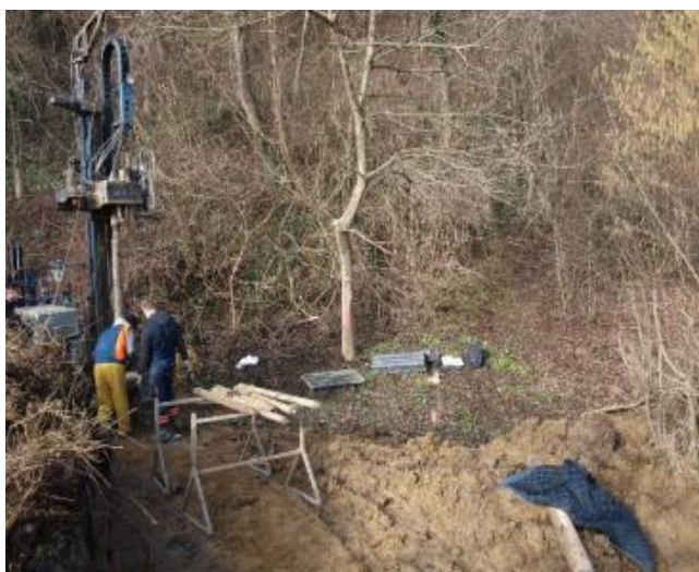
Slika 3. Bušača garnitura na lokaciji bušotine GP-22 [3]
