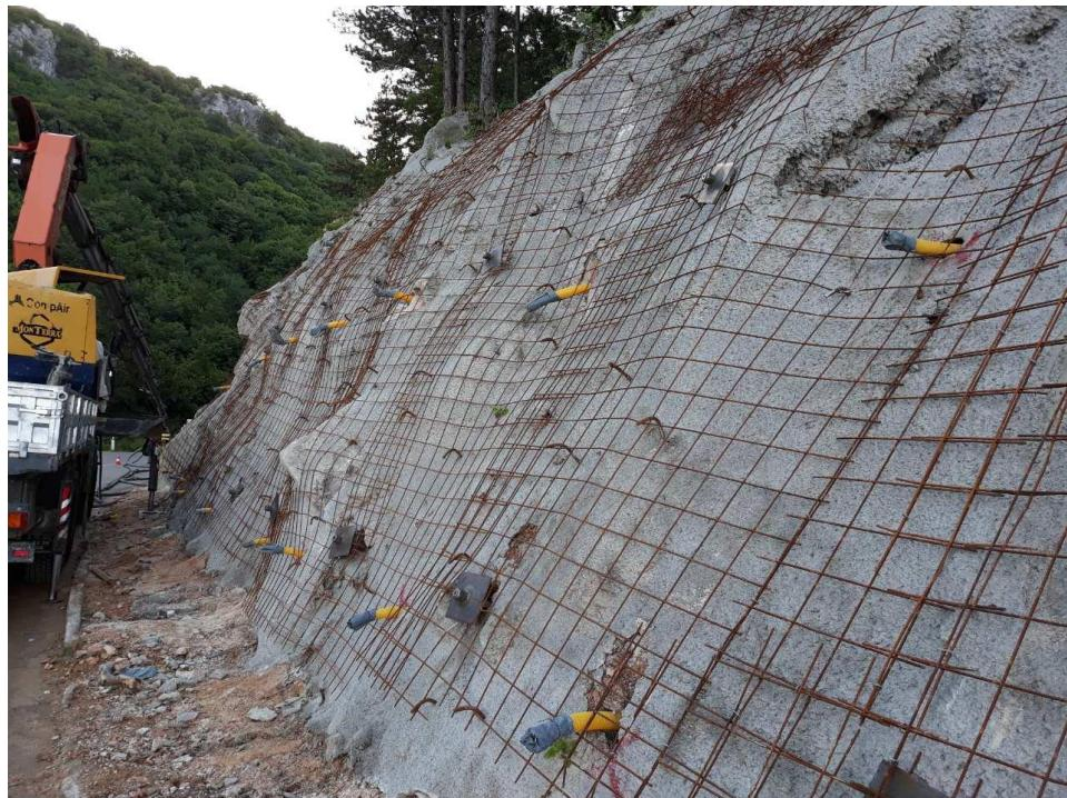
Slika 31. Zaštita kosine armaturnim mržzama na padinama. [14]
