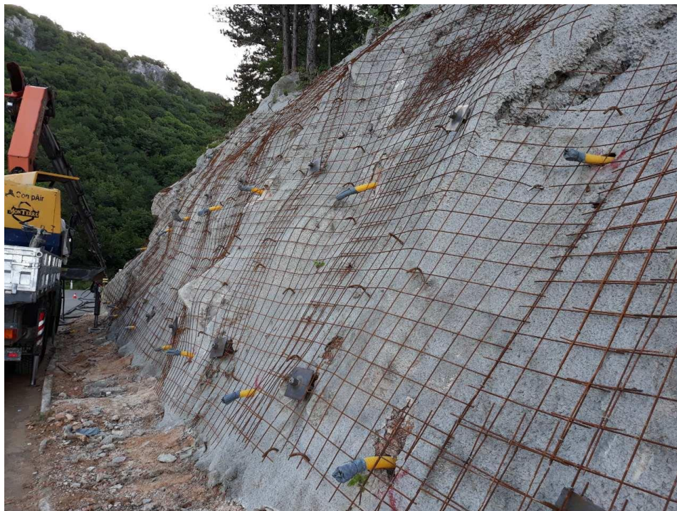
Slika 31. Zaštita kosine armaturnim mržama na padinama. [14]
