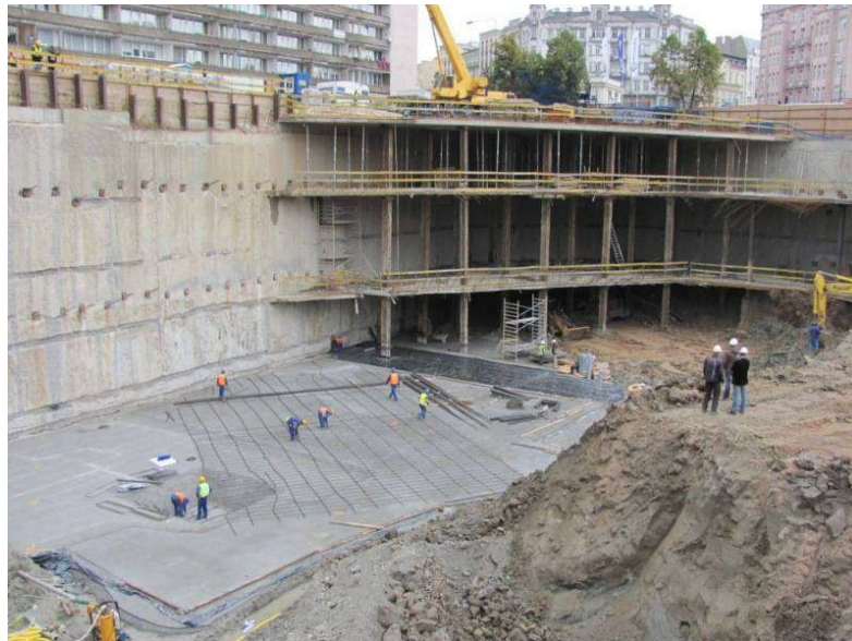
Slika 3. Primjer armirano – betonske dijafragme
