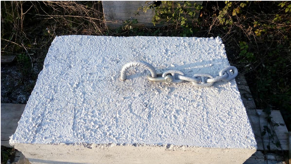
Slika 123 Primjer sidrenog betonskog bloka
