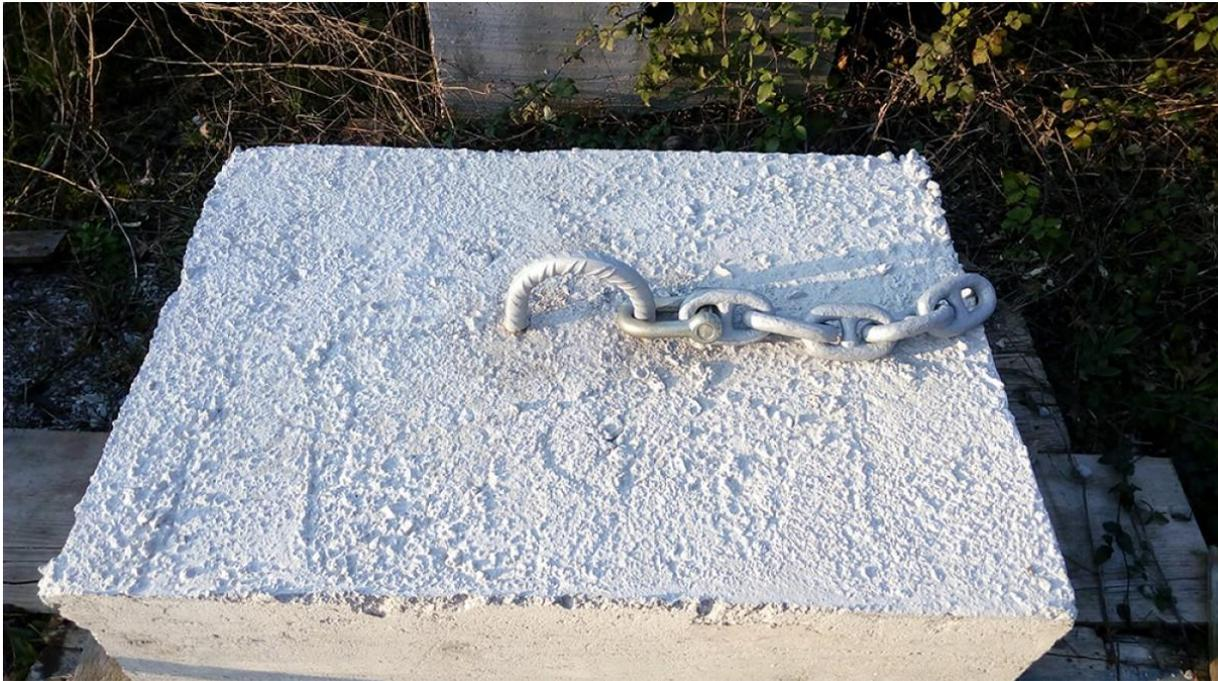
*Slika 123 Primjer sidrenog betonskog bloka*
