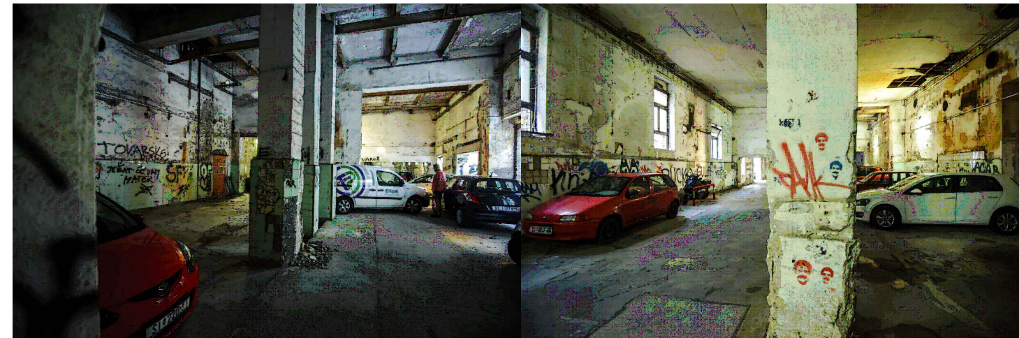
Slika 39.; 40. Prizemlje zgrade A - trenutno stanje
