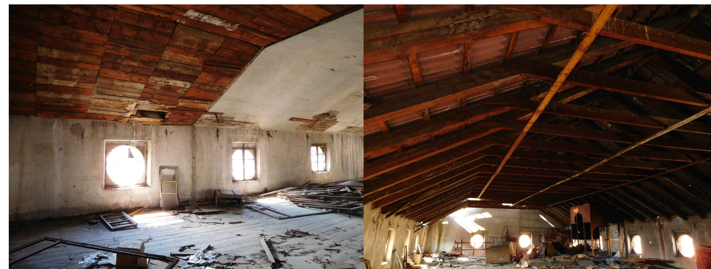
Slika 41.; 42. Podkrovlje zgrade A - trenutno stanje
