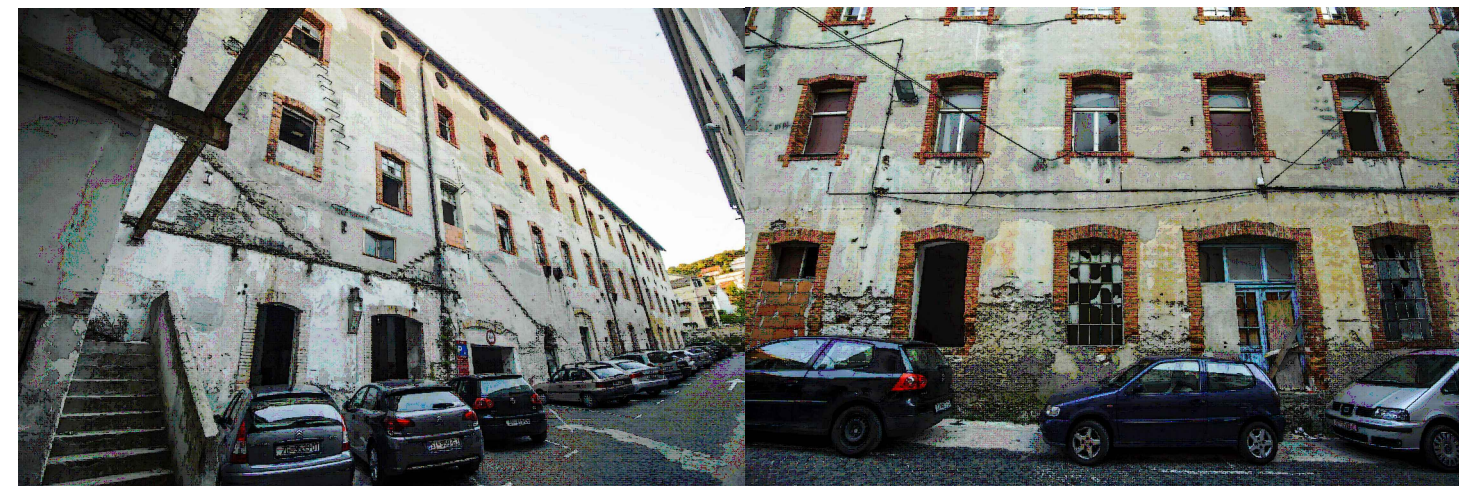
Slika 43.; 44. Dvorište kompleksa - trenutno stanje
