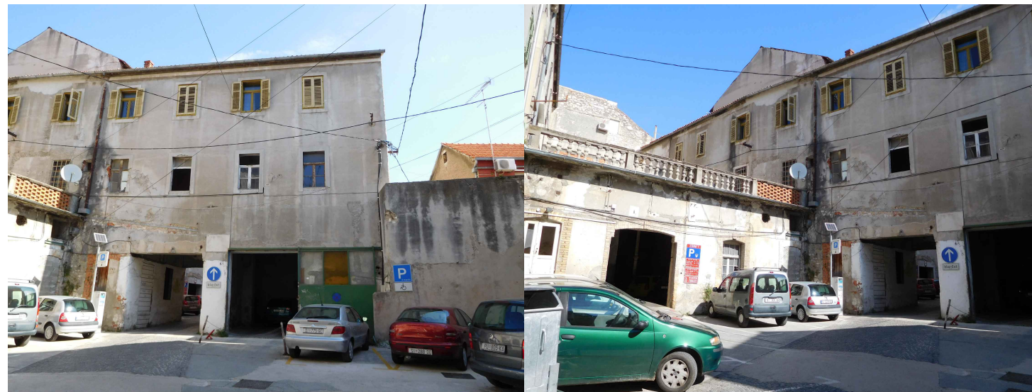
Slika 37. Zgrada D- Južno pročelje
