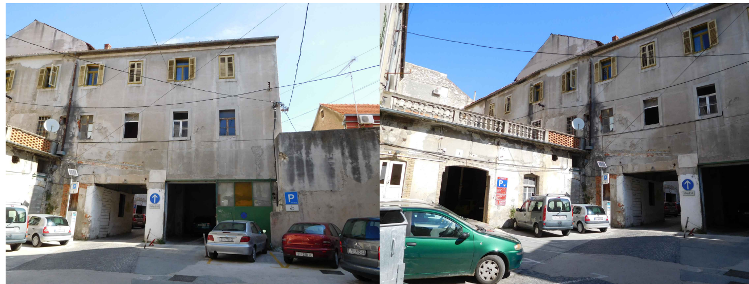
Slika 37. Zgrada D- Južno pročelje
