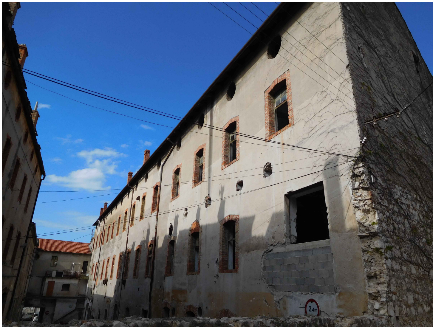
Slika 33. Zgrada B - istočno pročelje
