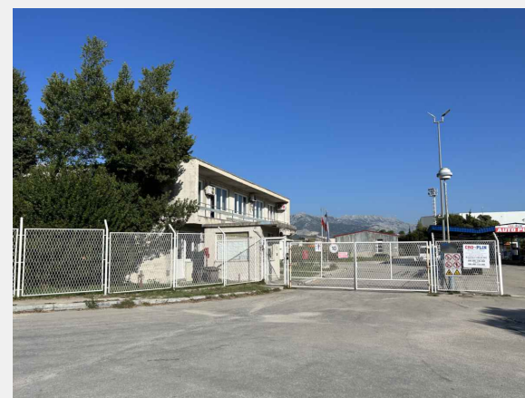
pogled na gospodarsku zgradu (INA CRO-PLIN) istočno od obuhvata
