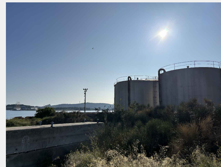
jugoistočni rub obuhvata uz more-spremište mazuta
