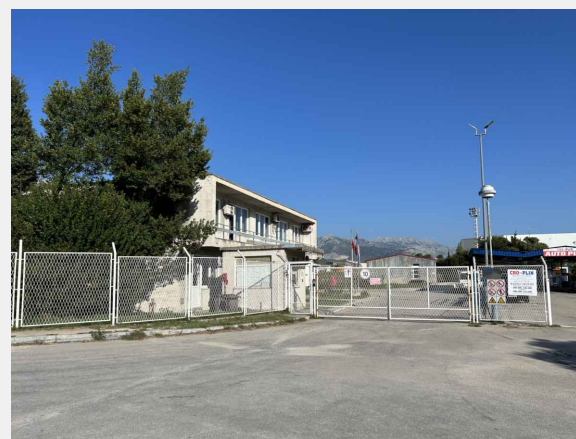
pogled na gospodarsku zgradu (INA CRO-PLIN) istočno od obuhvata
