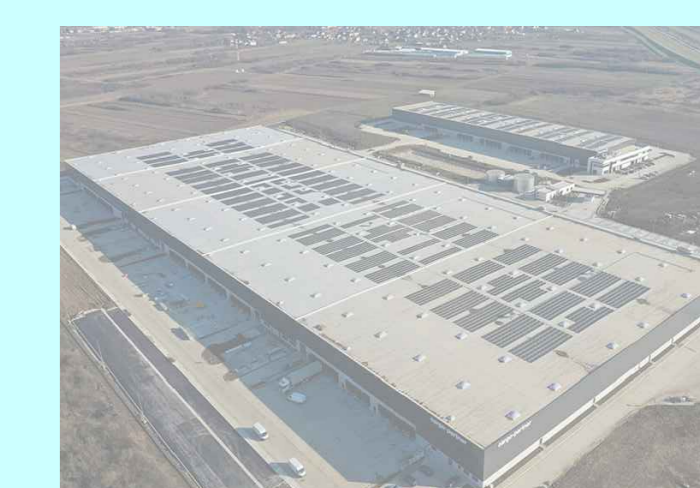
SOLARNE PLOČE NA KROVU
