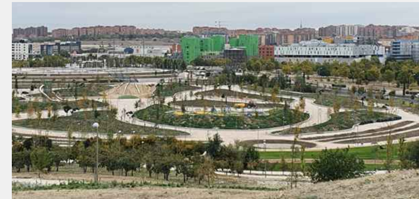
Izvedeni dio parka
