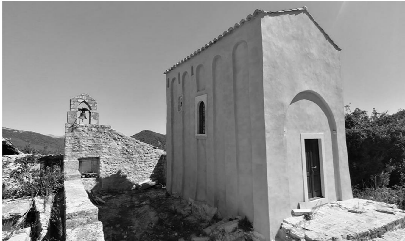
Crkva sv. Mihajla kod Stona – Pročelje; Foto: Nemanja Todorović Štimplja (6)
