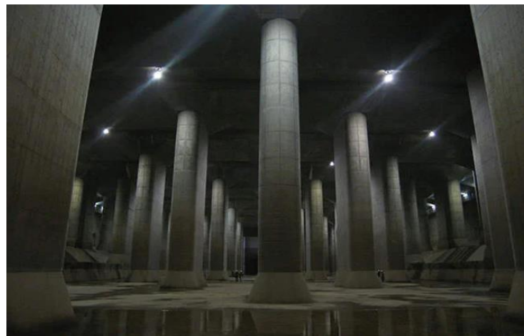
slika 8 – Prepumpna kontrolna stanica u sustavu G-Cans
