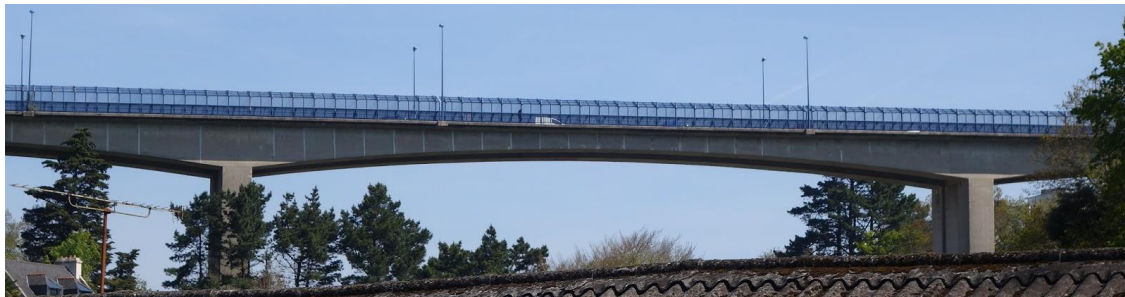
Figure 14. Vallon du Moulin a Poudre Bridge
