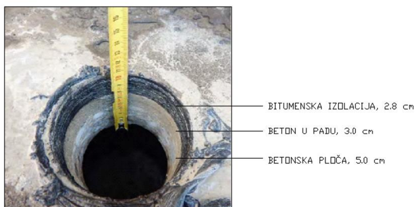
Slika 13: Fotografija uzorka pozicije 1 s definiranim pripadajućim slojevima [13]
