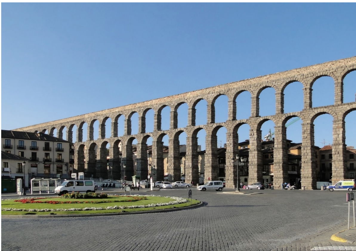
Fotografija 1.4 – Akvadukt Segovia, Španjolska
