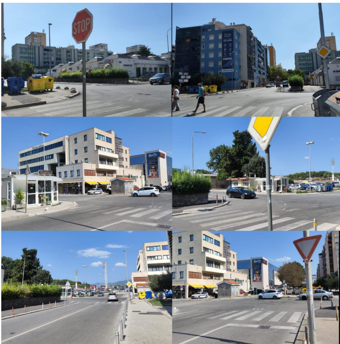
Slika 14 Situacija na terenu na križanju Ulice Mike Tripala, Velimira Terzića i Puta Brodarice
