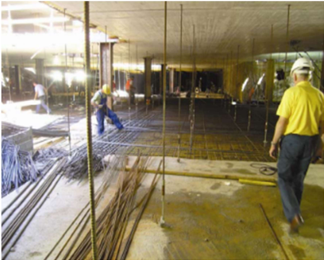
Slika 3.14 Viseći oplatni stolovi [1]
