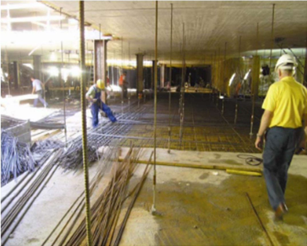
Slika 3.14 Viseći oplatni stolovi [1]
