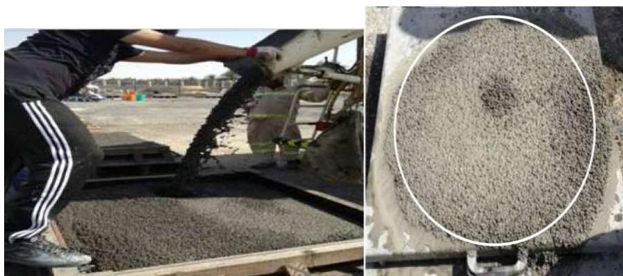
*Slika 5.10: a) izljevanje betona na mjestu ugradnje (lijevo); b) rasprostiranje slijeganjem-ispitivanje na terenu (desno)[17]*
