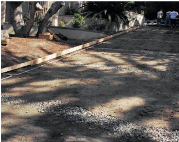
Slika 2.7 Priprema podloge kod ugradnje kolnika pod kutom [9]
