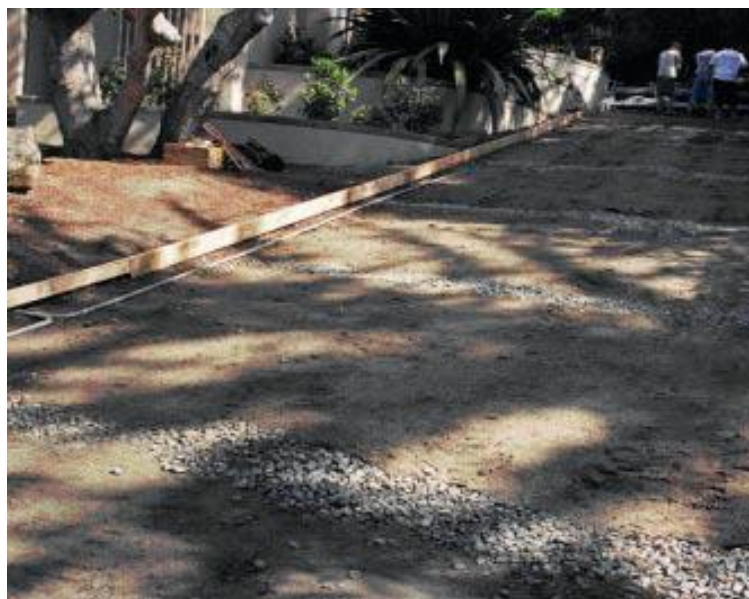
Slika 2.7 Priprema podloge kod ugradnje kolnika pod kutom [9]
