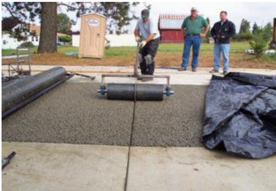
Slika 2.12 Upotreba valjka za oblikovanje dilatacijskih reški [9]
