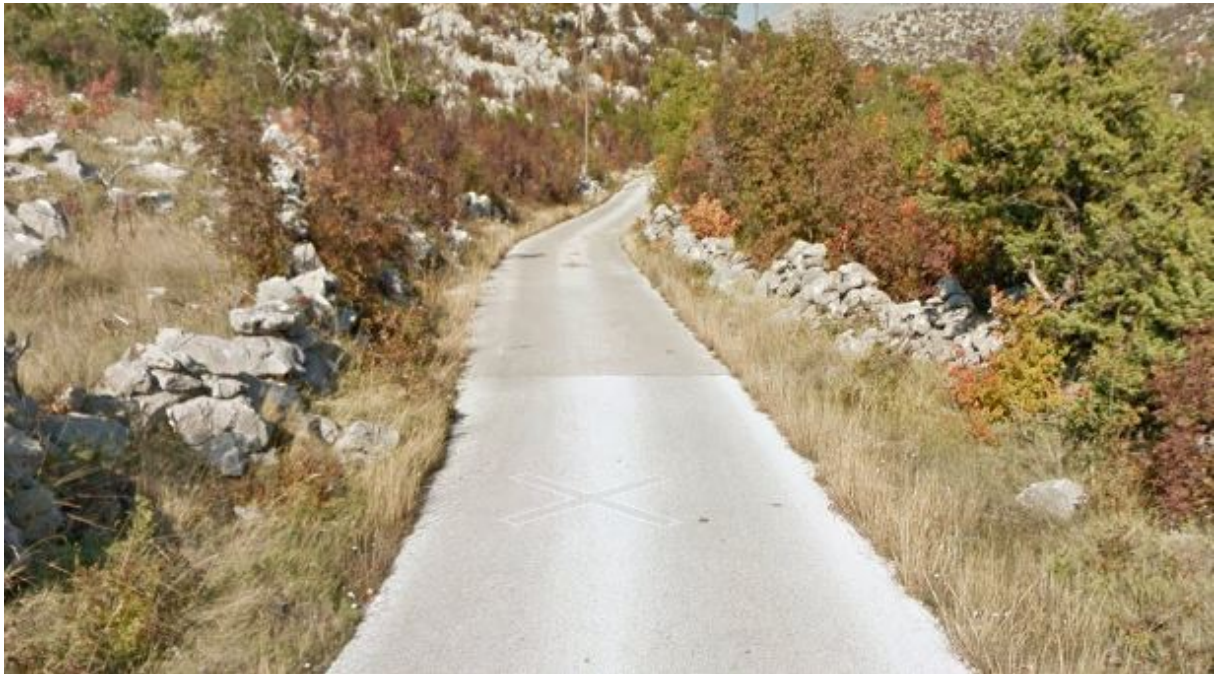
Slika 2. Prikaz postojećeg stanja prometnice OS 2
