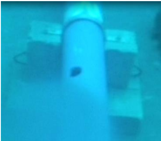
Slika 4. Prikaz bočnog otvora na difuzoru (promjer~8,5 cm) i podmetača difuzora
