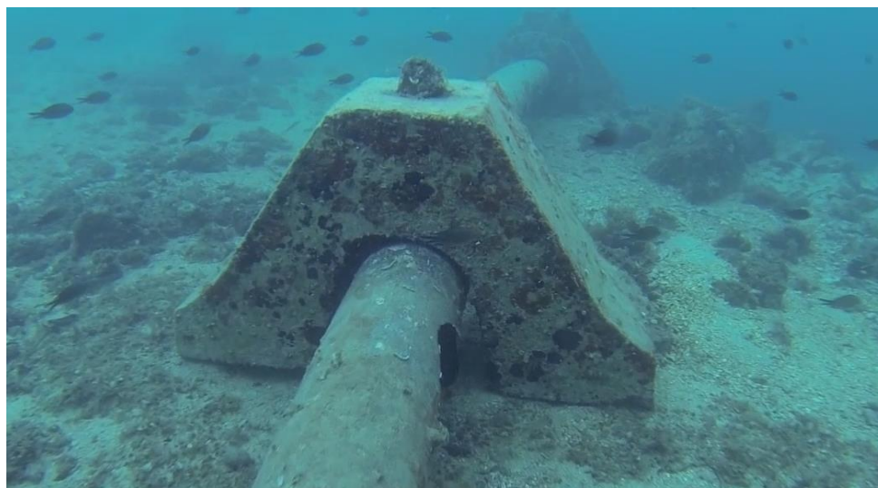
Slika 11. Sekundarni opteživač
