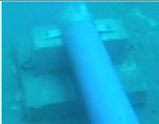
Slika 3. Detalj betonskog podmetača difuzora
