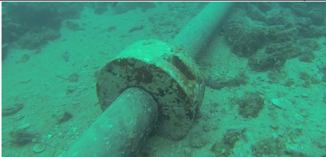
Slika 10. Primarni opteživač
