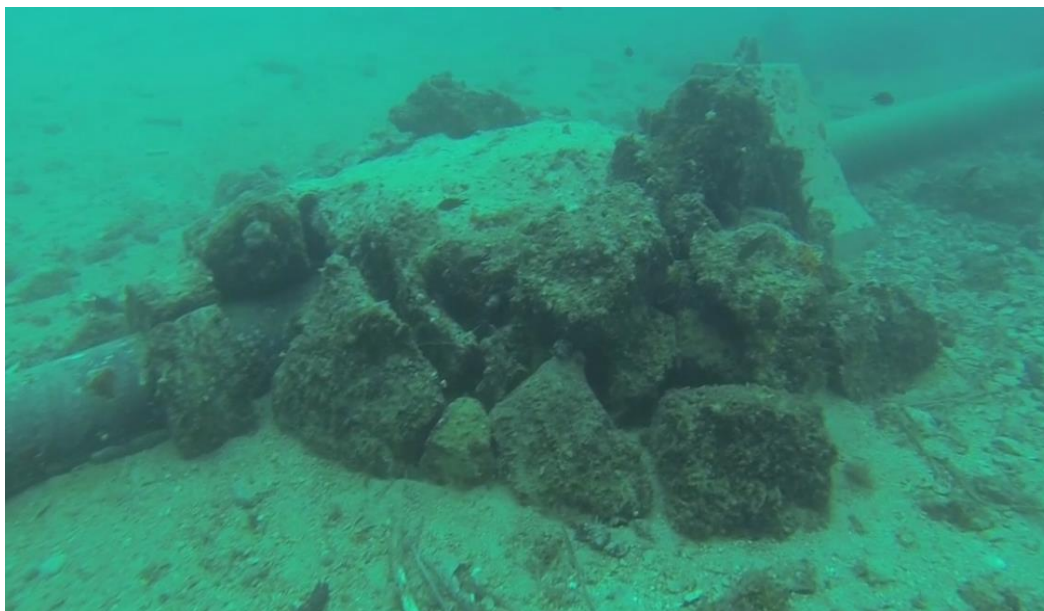
Slika 7. Zabetonirana prirubnica na spoju starog i novog cjevovoda
