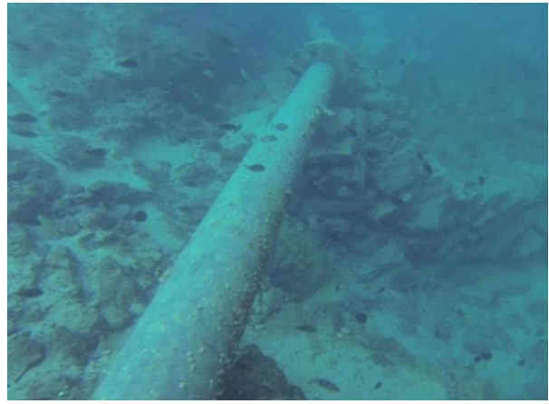
Slika 18. Vertikalni i horizontalni lom cjevovoda
