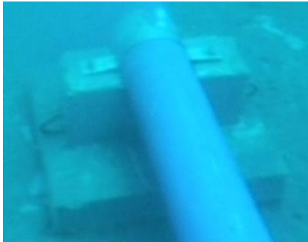
Slika 3. Detalj betonskog podmetača difuzora
