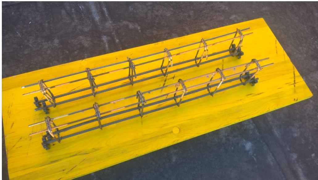
Fotografija 2.3. Armatura greda G1, G2 i G3
