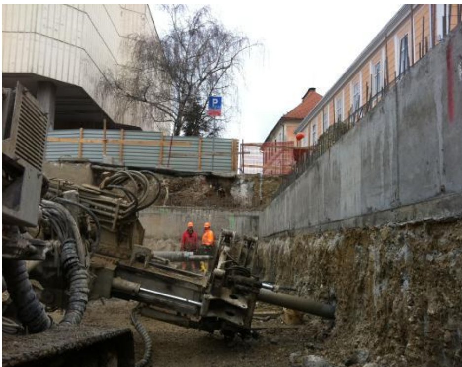
Slika 19. Ugradnja geotehničkih sidara
