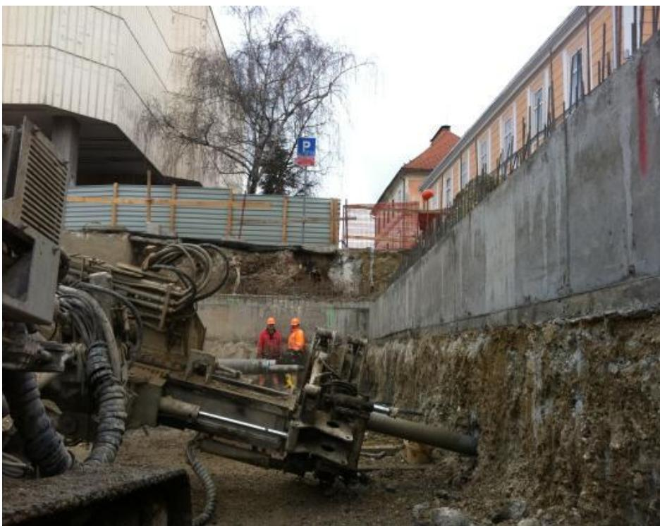
Slika 19. Ugradnja geotehničkih sidara
