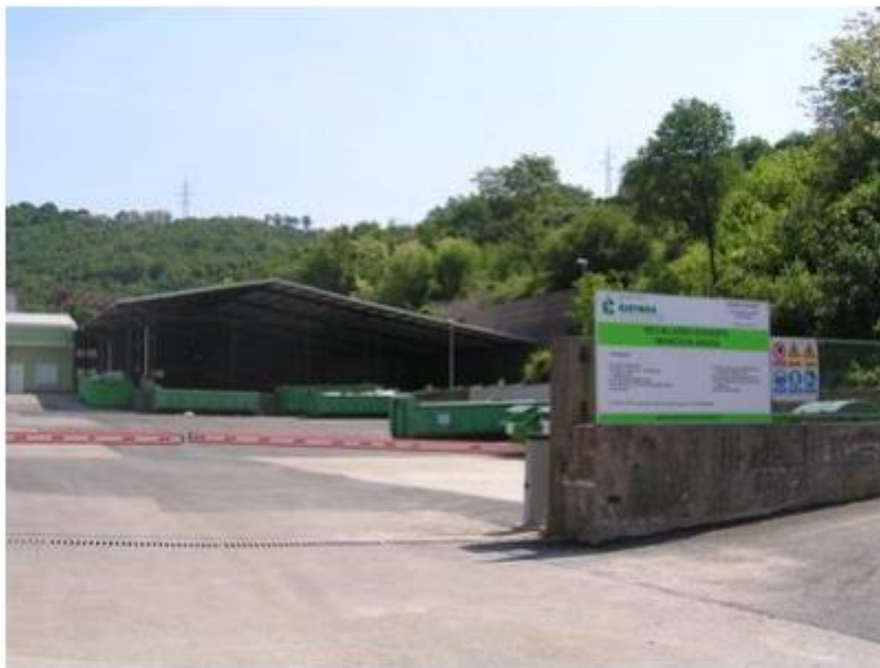
Slika 10.2. Primjer reciklažnog dvorišta
