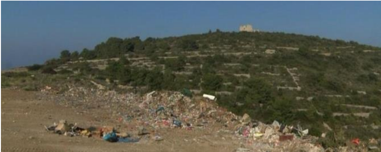
Slika 9.2. Pogled na odlagalište Wellington
