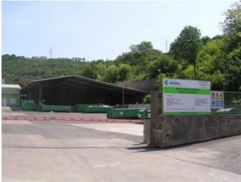
Slika 10.2. Primjer reciklažnog dvorišta
