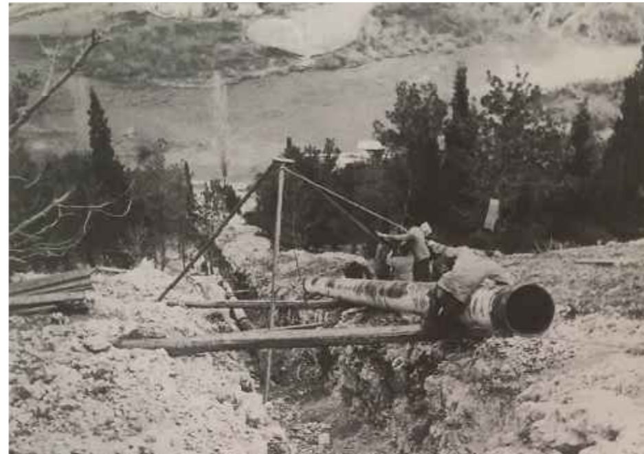
Radovi na vodovodu Krka - Ražine, 1951. godine
