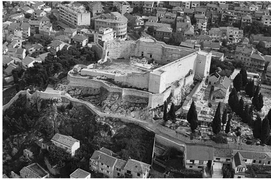
Tvrđava sv. Mihovila prije obnove
