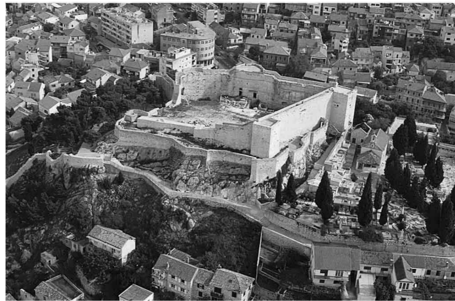
Tvrđava sv. Mihovila prije obnove
