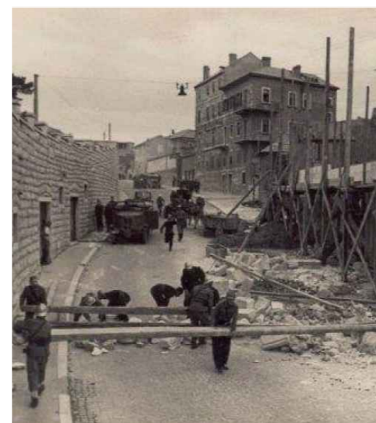
Izgradnja ceste u Šibeniku, 1857. god.
