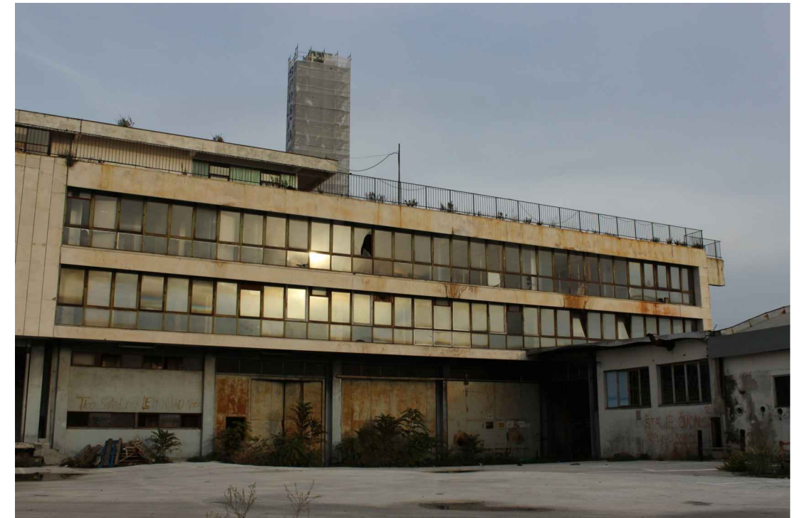
Slika 19. Zgrada skladišta - današnje stanje ( A. Burić)
