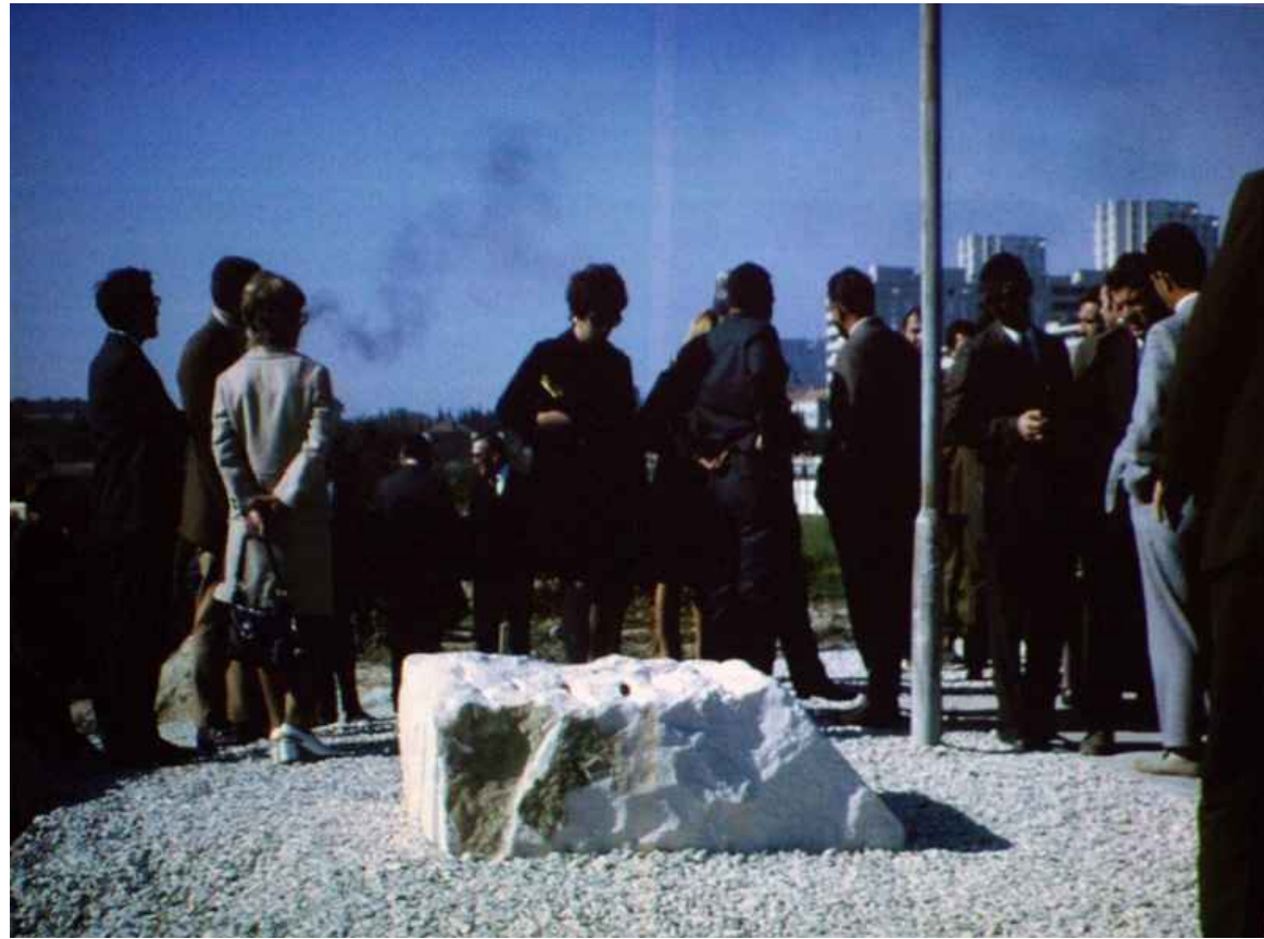
Polaganje kamena temeljca prije početka gradnje Splitska III
