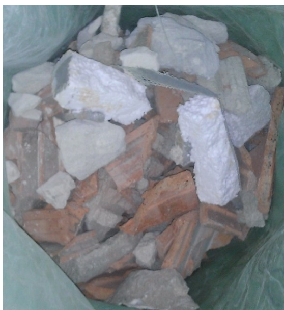
Slika 4.3. Betonski otpad prije mljevenja
