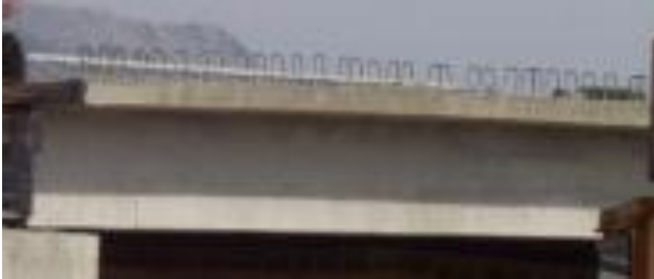
Slika 3. Armiranobetonski nosač
