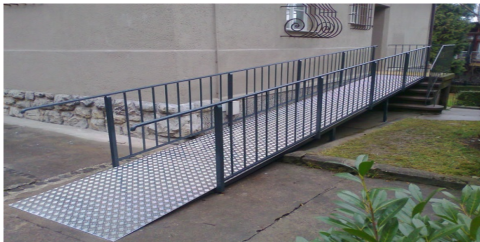
Slika 6.1. Rampa za invalide
