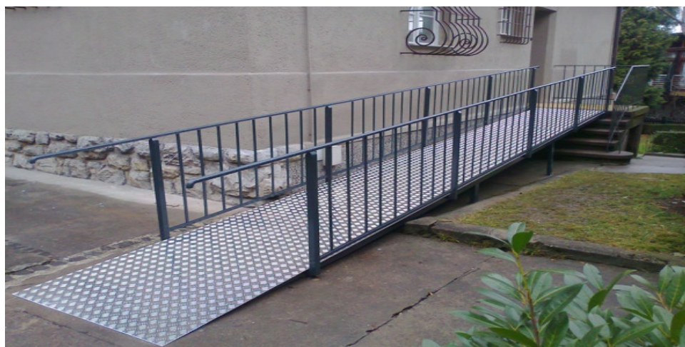
Slika 6.1. Rampa za invalide
