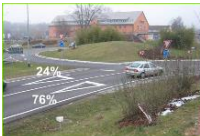
Slika 45. Postotak korištenja pojedinog voznog traka prilikom ulaska
