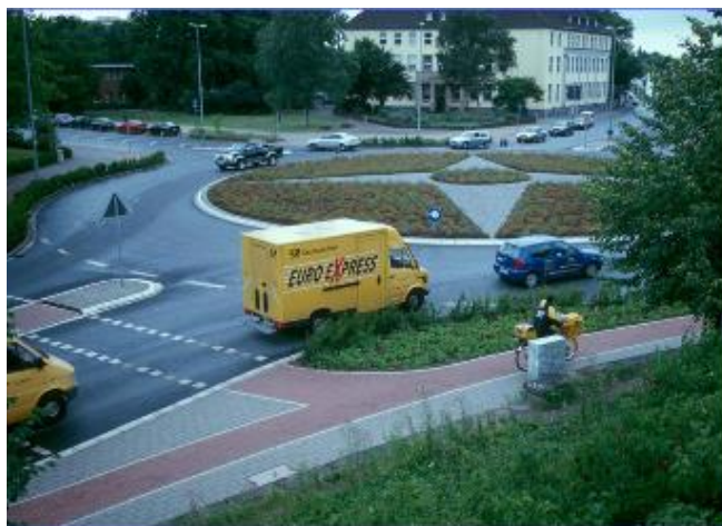
Slika 35. Urbani dvotračni kružni tok u Oberhausenu
