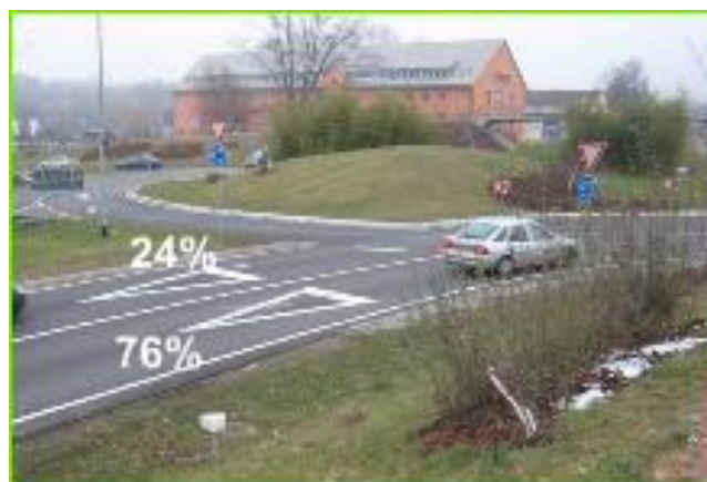
Slika 45. Postotak korištenja pojedinog voznog traka prilikom ulaska
