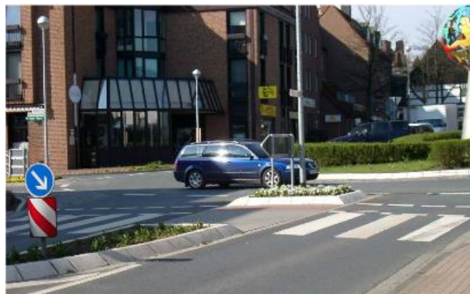
Slika 14: Pješački prijelaz na ulazu u kružni tok
