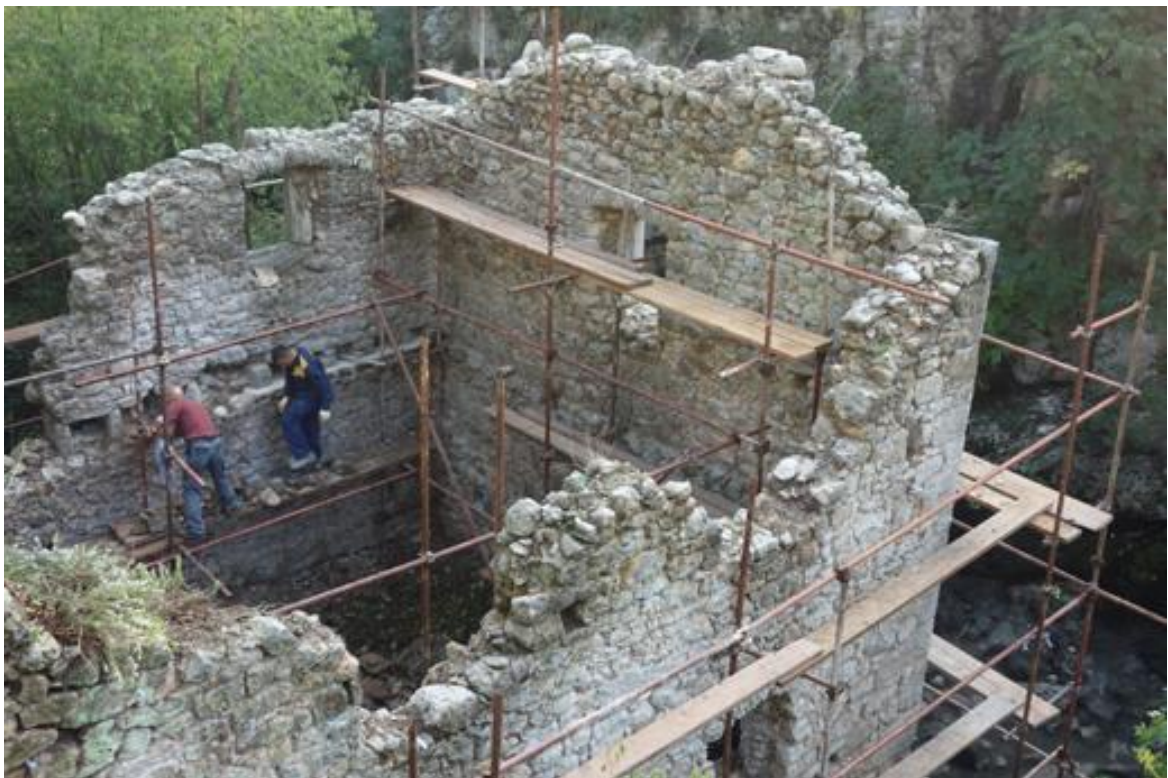
Slika 20. Obnova stare mlinice
