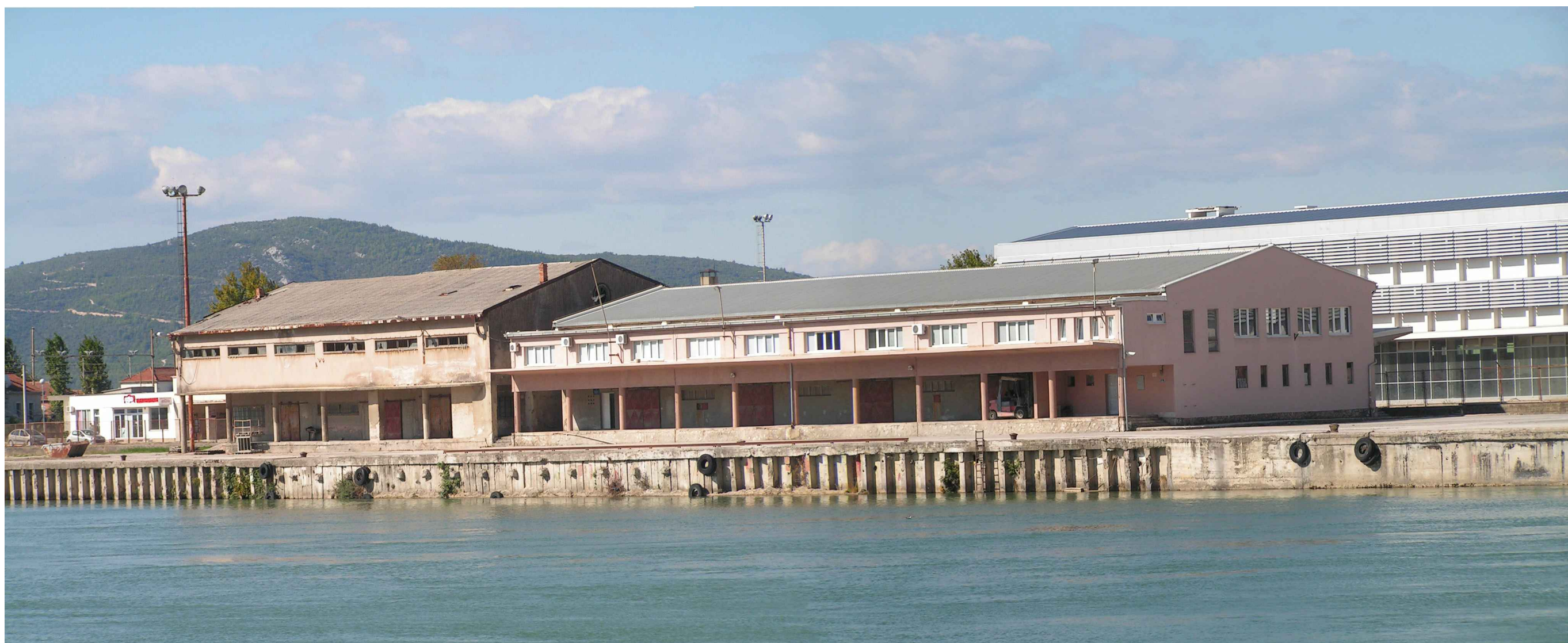
Pogled na dva preostala lučka skladišta - lijevo je u vrlo lošem stanju te je predviđeno rušenje
