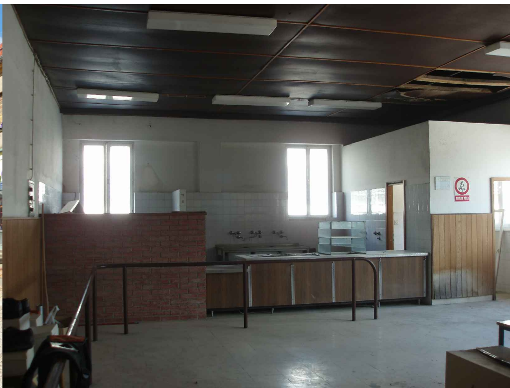
Postojeći prostor restorana za osoblje
