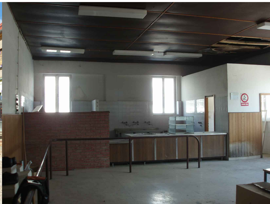
Postojeći prostor restorana za osoblje
