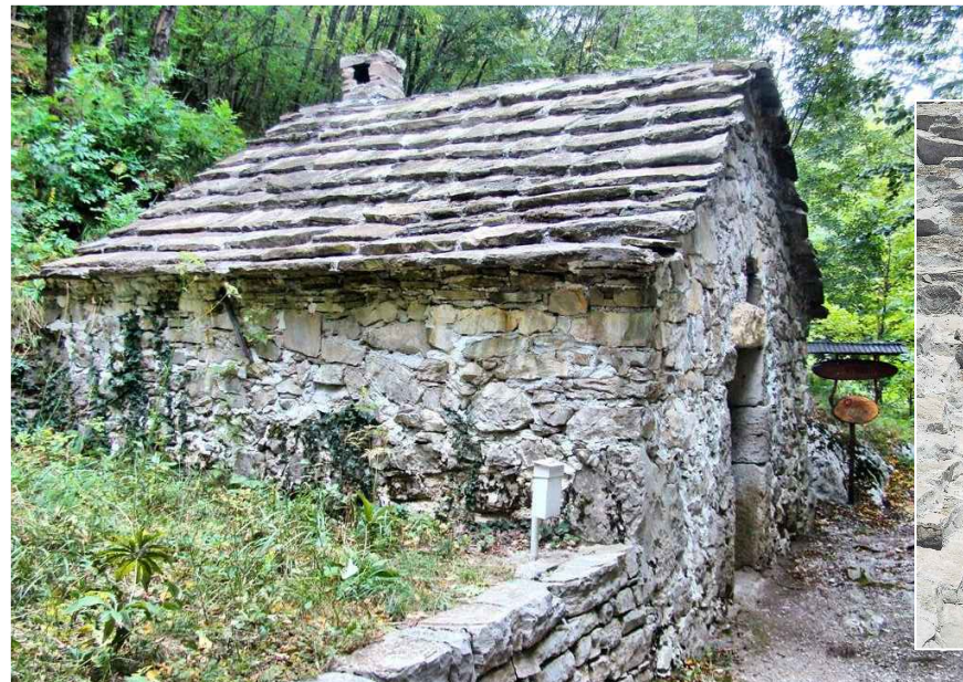
KAMENE PLOČE U VAPNENOM MORTU - korištene za pokrov starih poljičkih kuća
