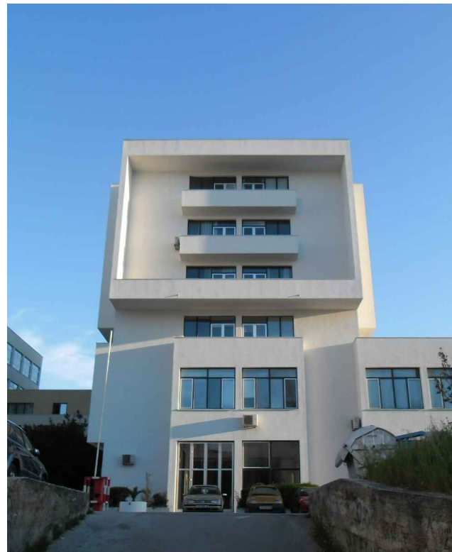
Južno pročelje B zgrade
