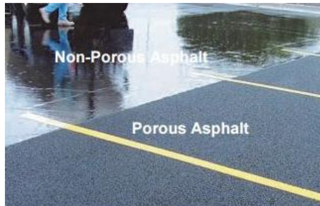
Slika 1.4 Odnos brzine sušenja između asfaltnog kolnika i kolnika od poroznog asfalt - betona [11]
