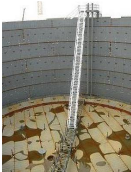
Slika 8. Plutajući krov
