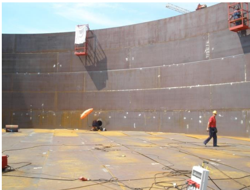
Slika 9. Plašt spremnika u izgradnji
