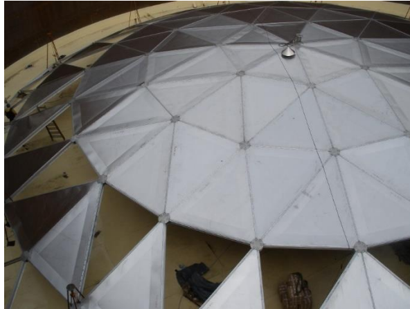
Slika 7. Aluminijska geodetska kupola u izgradnji
