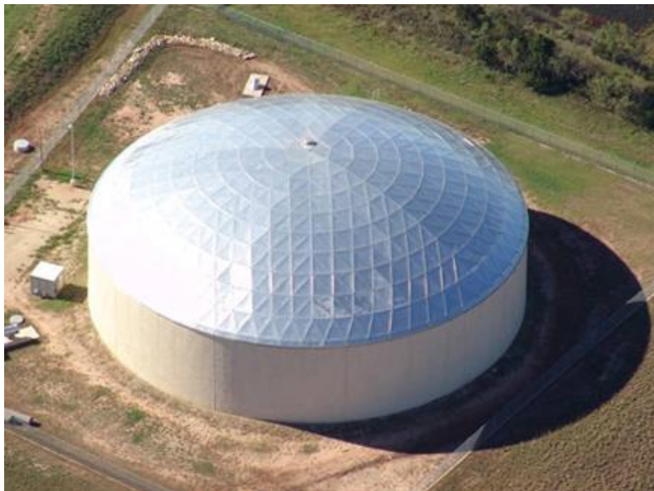
Slika 3. Nadzemni spremnik sa aluminijskom kupolom
