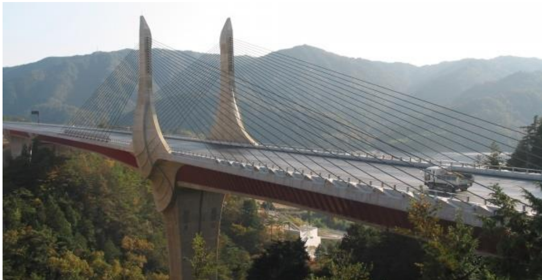
Slika 1.4.: Most Ritto Bridge [11]
