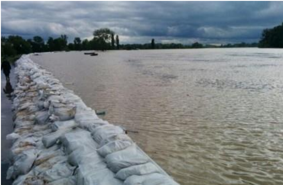
Slika 3.7.: Mjerna stanica Županja na rijeci Savi
