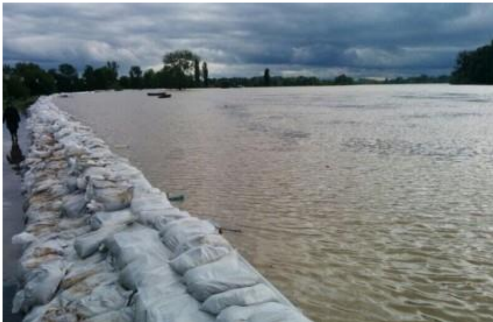
Slika 3.7.: Mjerna stanica Županja na rijeci Savi
