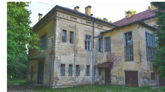
dvorac Bračak - prije obnove
