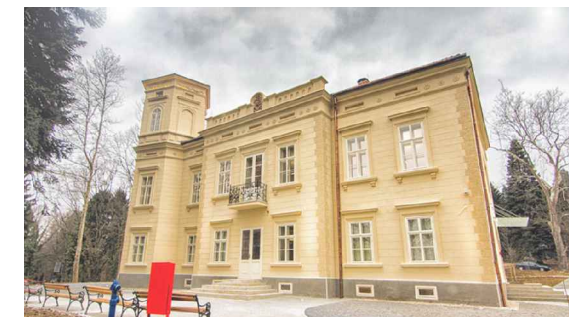
dvorac Bračak - nakon obnove
