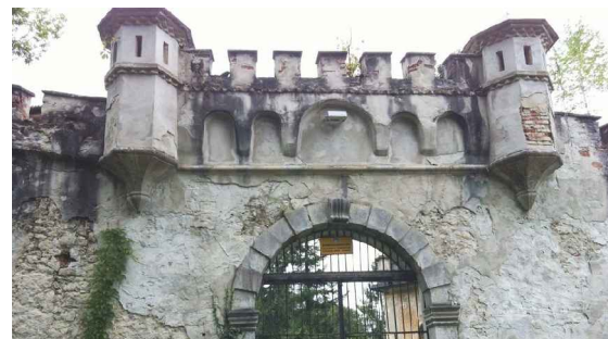
ulaz u dvorac
