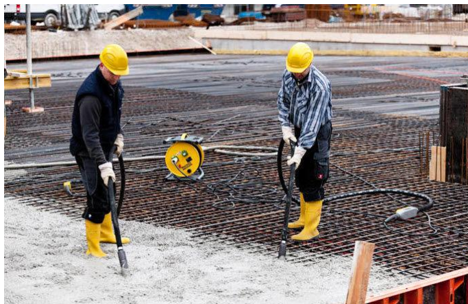
Slika 5.3. Korištenje vibro igle pri zbijanju betona [14]
