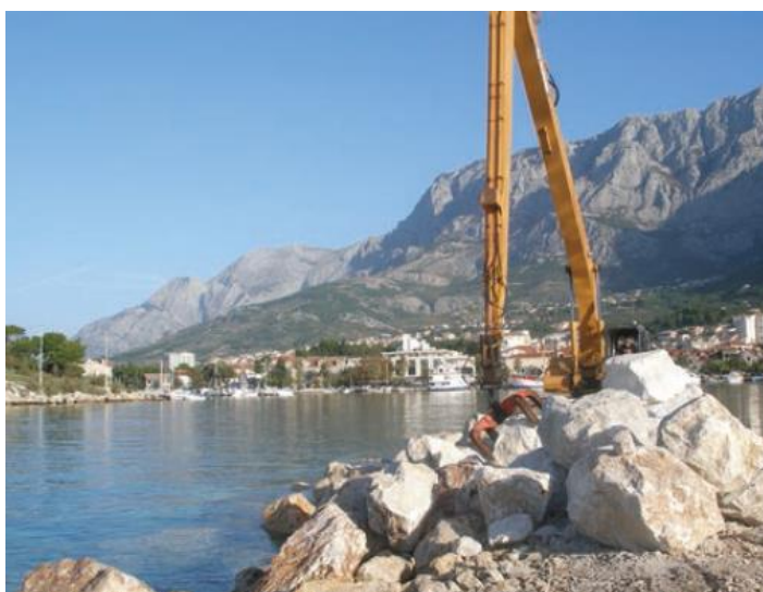
Slika 5.1. Postavljanje škojere pomoću plovne dizalice [1]
