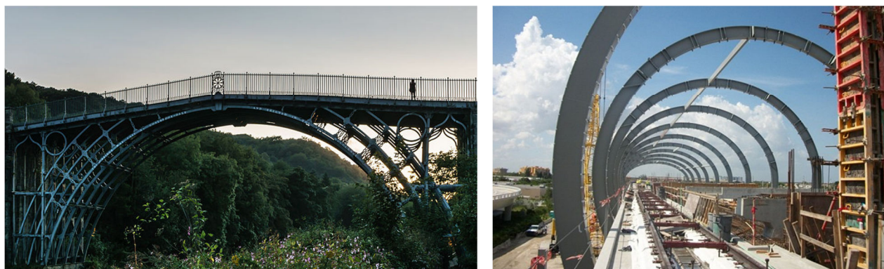
Slika 1.1 (a) Prvi lučni most od lijevanog željeza (b) Čelični eliptični lukovi u zračnoj luci Miami
