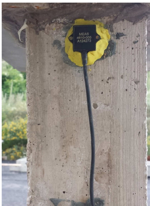
(a) Mjerenje ubrzanja na stupu
