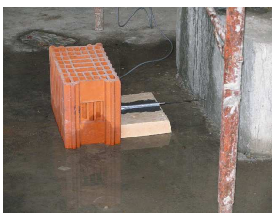
Slika 3.8. Prikaz mjerenja vertikalnog pomaka temelja (odizanje) omeđenog zida senzorom pomaka
