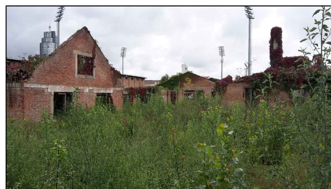
zatečeno stanje na parceli
