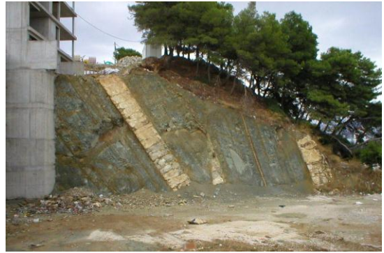
(b) 2004. (izrada zaštitne konstrukcije - I. faza)
