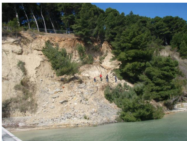
(a) Fotografija dan nakon klizanja (13.3.2010.)
