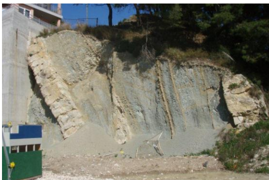
(e) 2010. (izrada zaštitne konstrukcije - II. faza)
